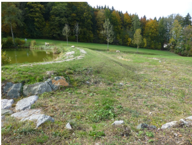
Dambereich mit Magerwiesenansaat und weiserseitigen Flachwasserbereichen.
