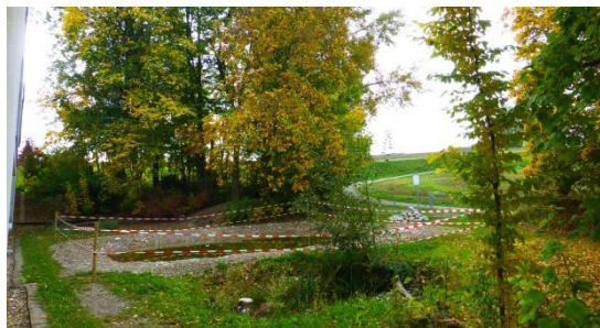
Sanierung eines Schulteichs im Sommer 2015/2018
